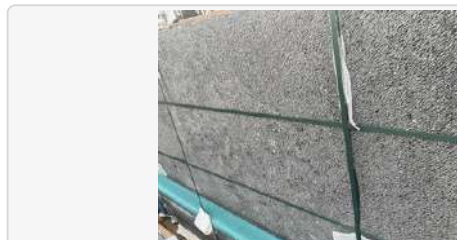
Dalle, pierre bleue Belge, surface taille ancienne mécanique, dim. 202x126cm
