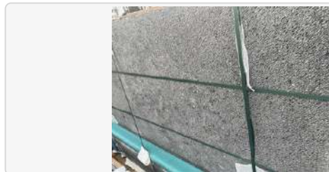
Dalle, pierre bleue Belge, surface taille ancienne mécanique, dim. 206x123cm
