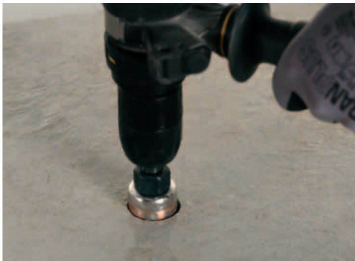
Perçage avec perforateur en rotation sans percussion avec trépan spécifique.
