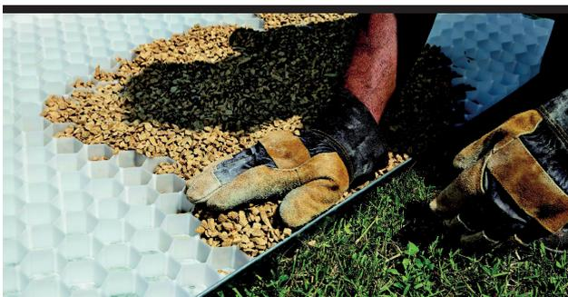
Pour l'aménagement d'un chemin, utilisez cette structure alvéolée: la solution recommandée pour stabiliser les concassés et galets. Un résultat stable, solide et durable.
