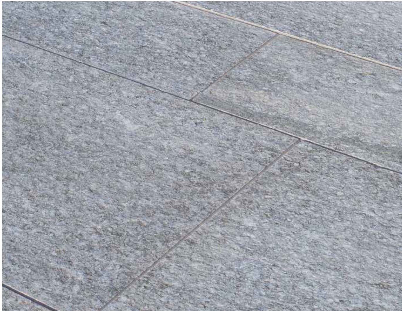
Pierre gneiss pour dallages à épaisseur calibrée de 2 à 5 cm, avec surface flammée et des bords sciés.
