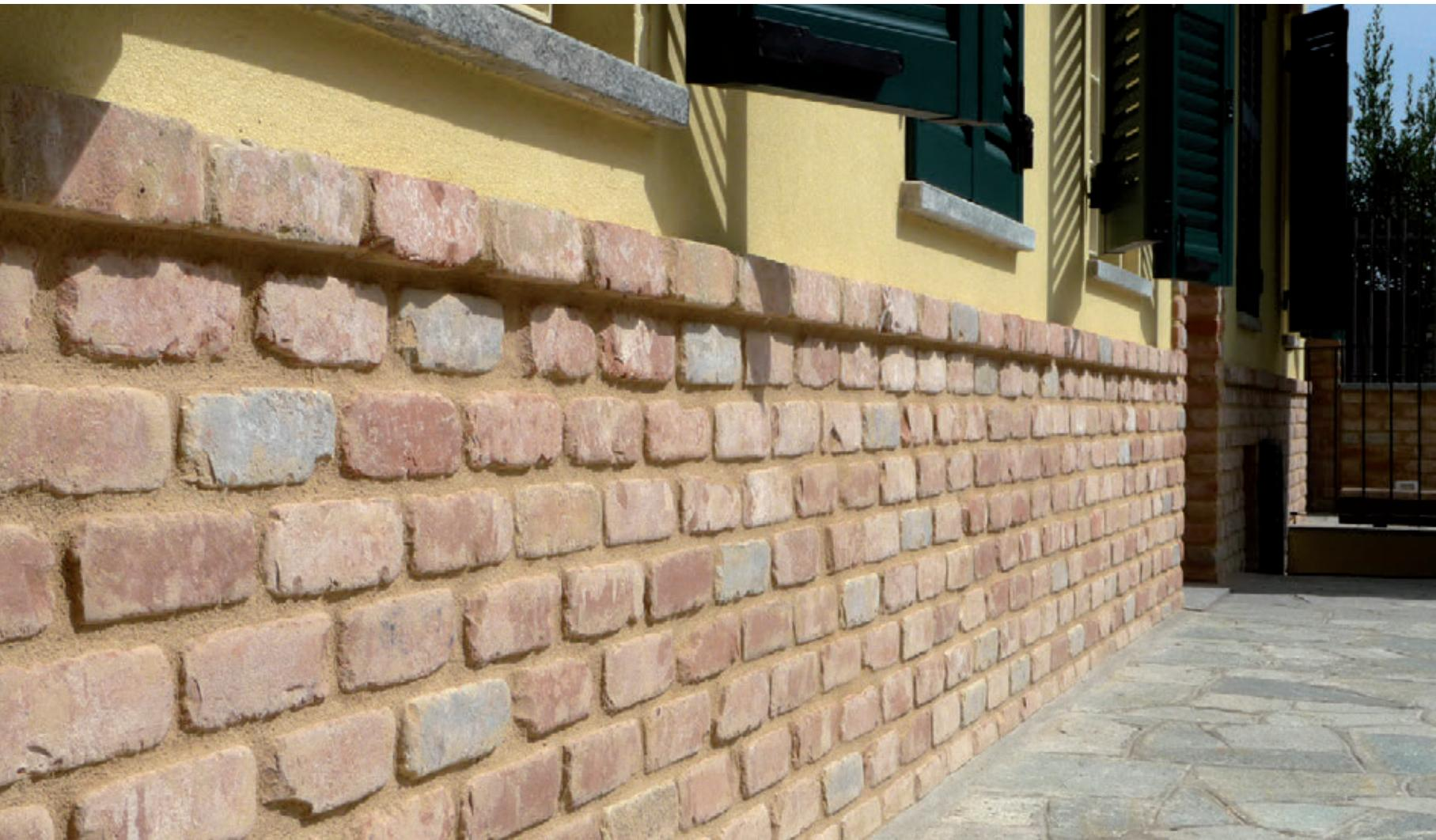
I mattoni pieni Genesis 215 sono sottoposti ad un'alterazione superficiale, in modo da ottenere l'aspetto di un mattone di recupero, presentano residui di malta e spigoli arrotondati, che li fanno apparire come se fossero stati esposti alle intemperie per molti anni, alla demolizione ed alla pulizia.
