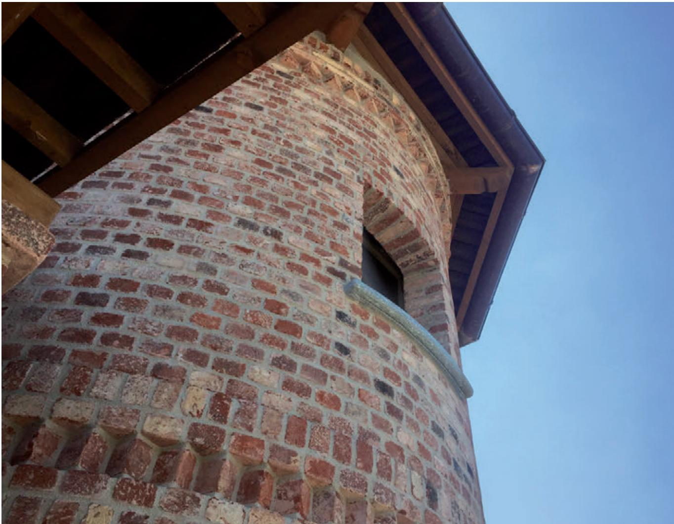
I mattoni pieni Genesis 002 sono sottoposti ad un'alterazione superficiale, in modo da ottenere l'aspetto di un mattone di recupero, presentano residui di malta e spigoli arrotondati, che li fanno apparire come se fossero stati esposti alle intemperie per molti anni, alla demolizione ed alla pulizia.
